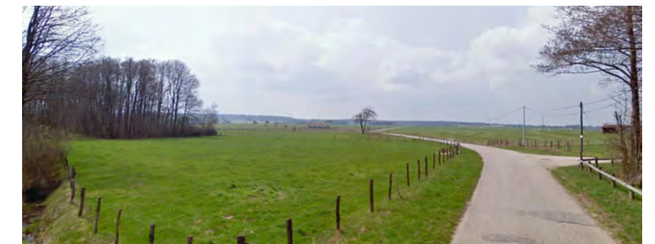
Photo 96 : Vue sur le site d'implantation direction Sud
